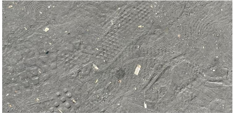
Fußspuren im Asphalt: Durch die Hitze wurde der Asphalt so weich, dass sich Fußspuren abzeichneten.
